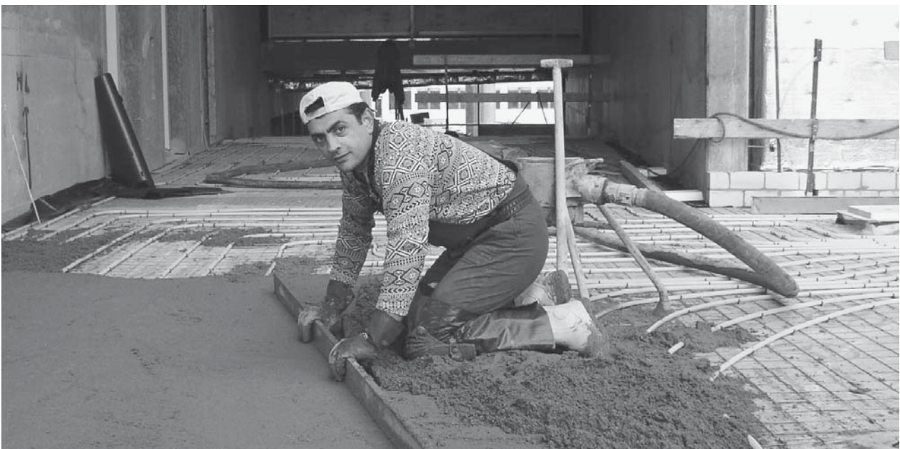
Bild 1: Estricheinbau
