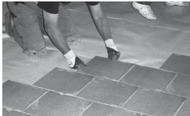
Bild 7: Fertigteilstrich aus zementgebundenen Platten
