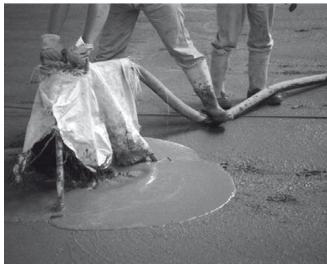
Bild 6: Ausbringen des Hartstoffestrichs frisch in frisch
