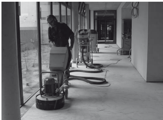
Bild 8: Anschleifen eines Zementestrichs
